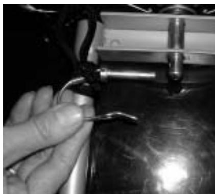
Schieben Sie den Federclipbolzen durch
